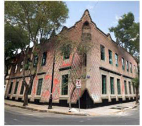
Muros de carga de mampostería
