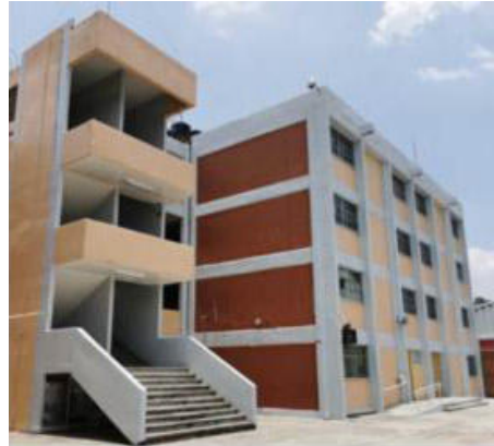
Marco rígido de concreto
